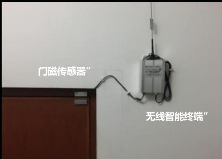
门磁传感器可监测防火门开闭状态，用于监测常开或常闭的防火门状态，用以保持防火门正常状态
